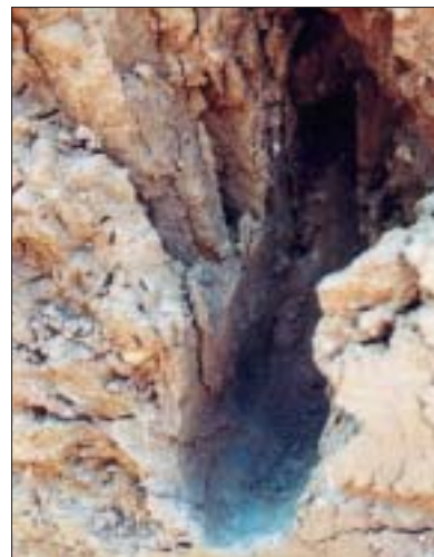
Lissage de la dent + fissuration en triangle.
