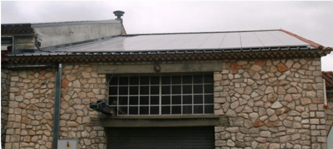
Figure 5 : Panneaux photovoltaïques (Lieu : Cave coopérative les Coteaux du Pic à Valflaunès, 34) Source : IFV Epernay
